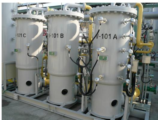
図5 PSA吸着塔（右からA塔、B塔、C塔）
